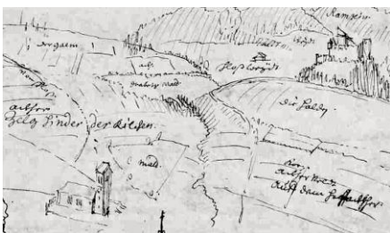
G.F.Meyer: Kirche Bretzwil und Schloss Ramstein 1680: sichtbar ist noch das alte, vorreformatorische Kirchenschiff mit dem „reformierten“ Turm von 1624.
